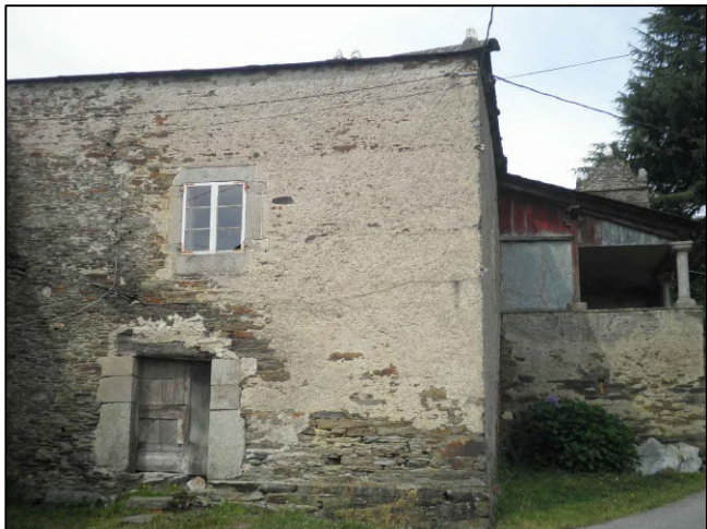
Casa Fachada Posterior
